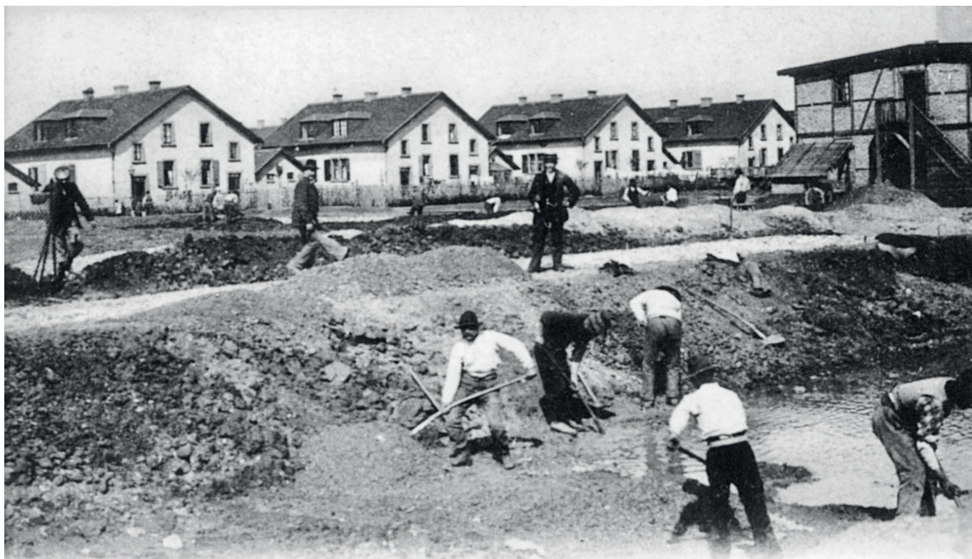
Construction de la première Kolonie Stahlheim.
