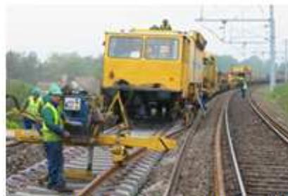
Longs Rails soudés sur traverses béton
